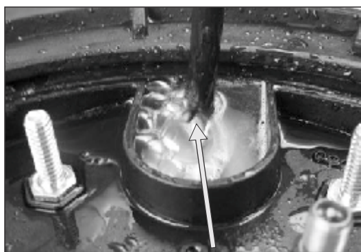
Únik v místě kabelového vstupu.
